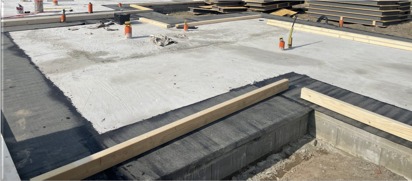
Szerelőbeton vízszigetelése bitumenes lemezzel
